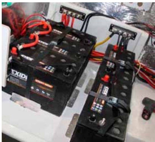
Exempel på montering av batteribank med kraftiga AGM-batterier.
